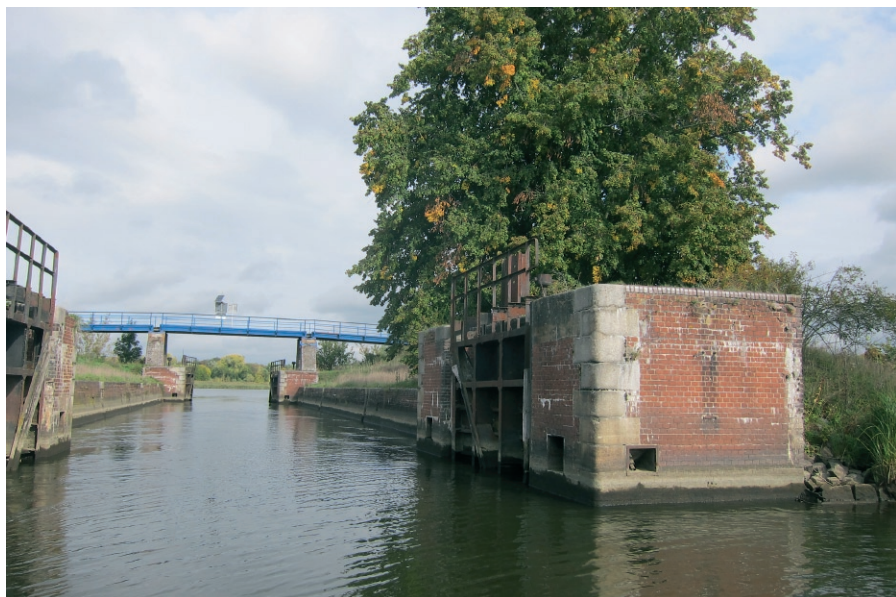
Fot. 36. Zabytkowa śluza łącząca Odrę Zachodnią z szerokim kanałem Międzyodrza – Starą Regalicą. Fot. Dominik Marchowski
